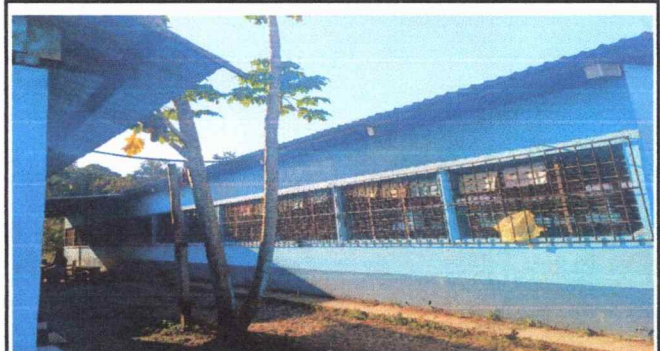
Foto 3: Instalacion de corredor y piso de cocina.
